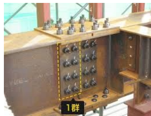
図.3 従来の仮止め作業 (イメージ)
