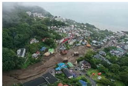
図.1 土砂崩れで被災した民家など
